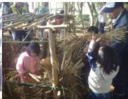
★まずは外壁工事から…
